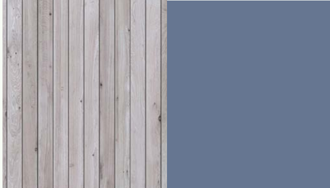
Belattung Lärche Stahlunterkonstruktion Pulverbeschichtung Taubenblau RAL 5014
